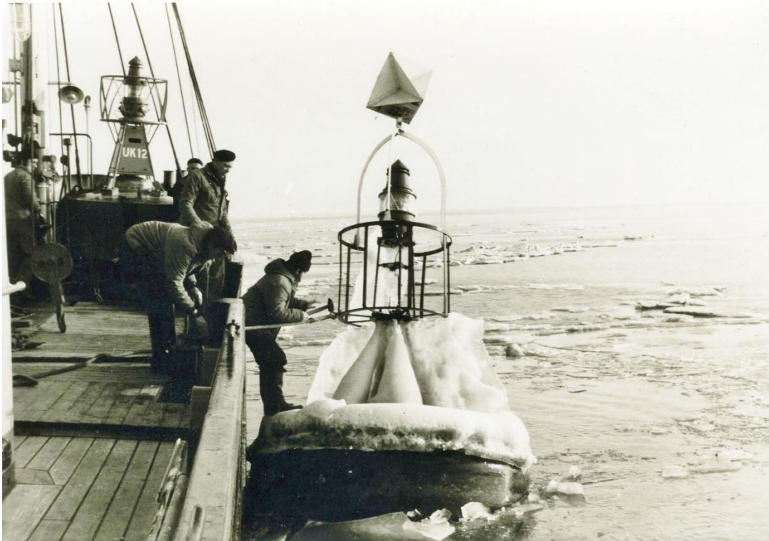
De betonning wordt weggehaald en vervangen door sparboeien. (collectie Berend van der Veer)
